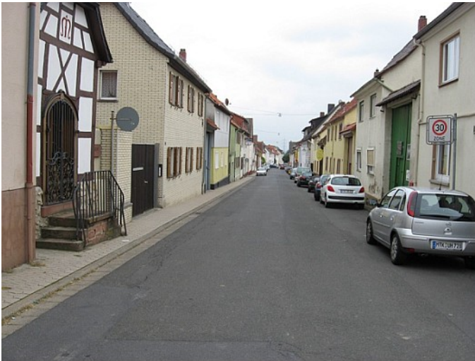
Abbildung 11: fehlender Gehweg Schulstraße
