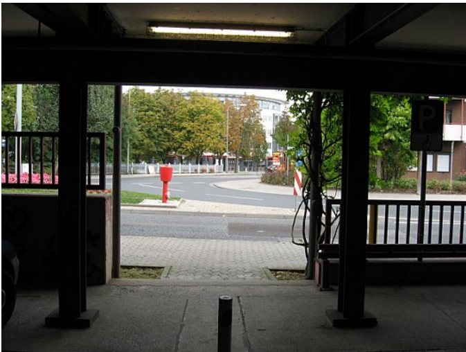
Abbildung 16: Fußgängerausgang Parkhaus am Bahnhof
