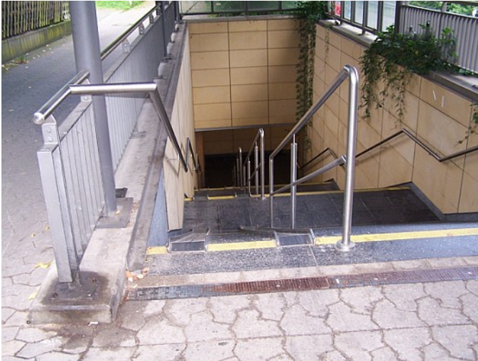
Abbildung 7: Schieberinne an Treppenanlage südliche Bahnunterführung
