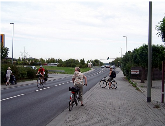
Abbildung 6: fehlende Schutzeinrichtung Niederhofheimer Straße
