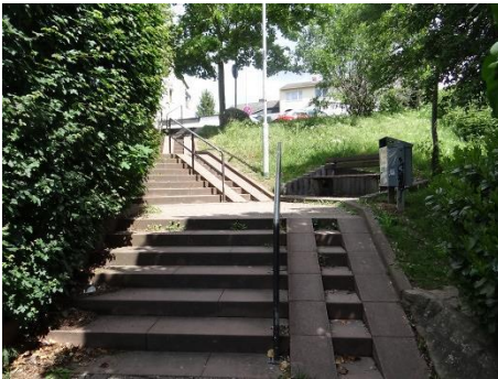
Treppenanlage Oskar-Meyrer-Straße, VB 1
