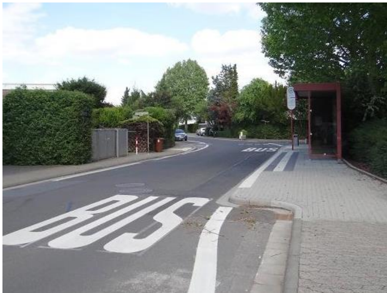
Barrierefrei ausgebaute Haltestelle mit entsprechender Ausstattung in der Frankfurter Straße in Hofheim, Foto: LK Argus
