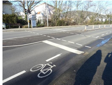
Schutzstreifen im Bereich Rheingaubrücke, VB 3/ VB 2
