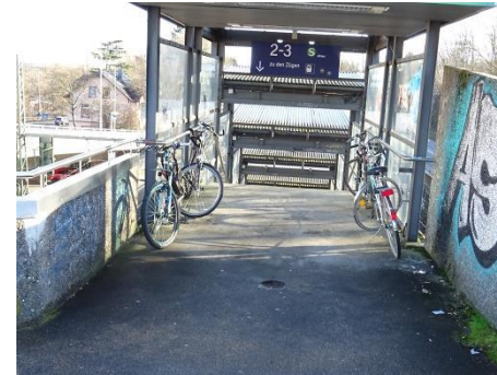
Gleisabgang an der Rheingaubrücke, VB 3
