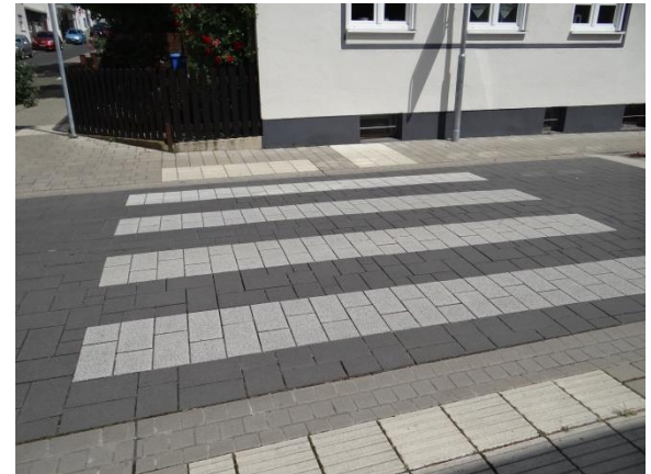
Neu gestaltete barrierefreie Querungsstellen mit taktilen Leitelementen im Bereich Ostendstraße/ Schulgelände Brühlwiesen, Fotos: LK Argus
