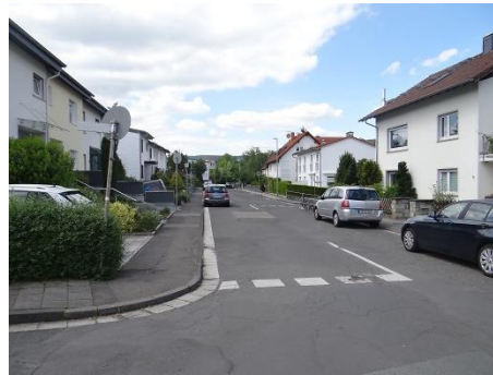
fehlende Bordsteinabsenkung, Bsp. Cimbernstraße, VB 2
