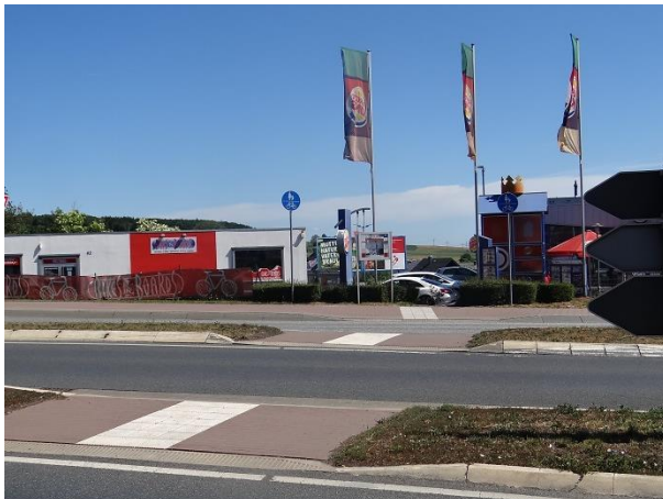
Überwege mit Bordsteinabsenkungen und taktilen Leitelementen an der Großen Wendelstraße in Butzbach, Foto: LK Argus
