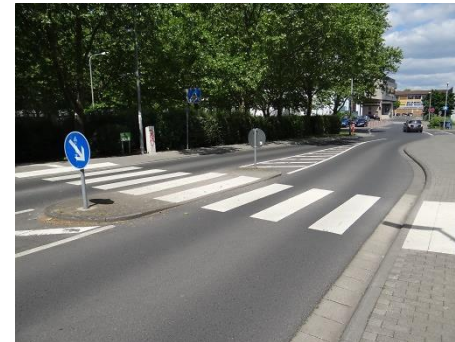
Überweg im Bereich Schwarzbach, Rudolf-Mohr-Straße; VB 1
