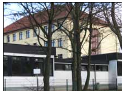
Abb. 98 | Pavillon für Betreuungsangebote an der Pestalozzi-Schule [Quelle: NH]
