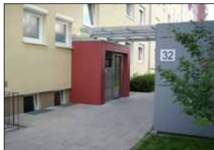
Abb. 119 | Eingangssituation, Zeilensanierung in der Kleiststraße, Darmstadt,
