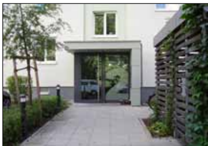
Abb. 118 | Eingangssituation, Zeilensanierung im Braunschardtter Weg, Darmstadt [Quelle: NH]
