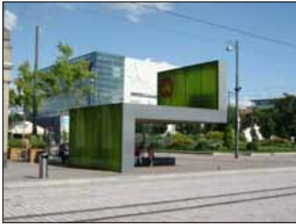
Abb. 154 | Haltestelle am Hauptbahnhof in Darmstadt [Quelle: NH]
