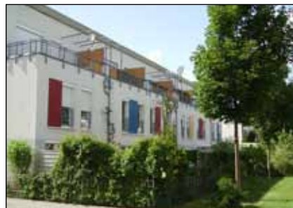
Abb. 135 | Wohnen mit Garten, Europaviertel in Darmstadt [Quelle: NH]
