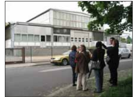
Abb. 103 | Firma POLAR Mohr im Quartier Hofheim Nord [Quelle: NH]
