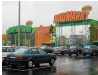
Abb. 102 | Globus Baumarkt im angrenzenden Gewerbegebiet Nord [Quelle: NH]
