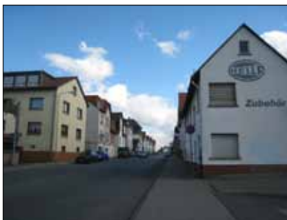
Abb. 32 | Bebauung Niederhofheimer Straße [Quelle: NH]
