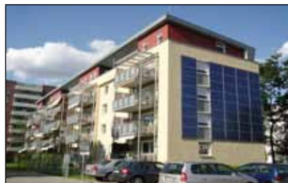
Abb. 117 | Beispiel einer Zeilensanierung in der Kleiststraße 32-36 in Arheilgen-Darmstadt, Dörfer Architekten [Quelle: NH]
