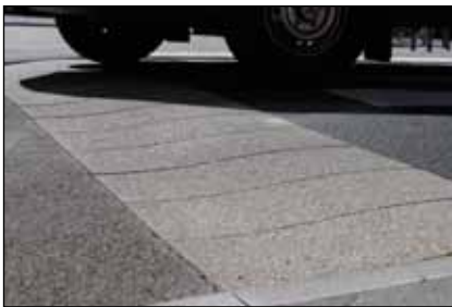
Abb. 149 | Bodenwellen zum Entschleunigen des Verkehrs in Frankfurt am Main [Quelle: NH]
